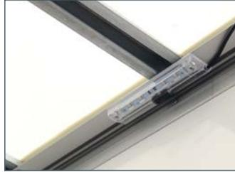
Lichtbahndach besteht aus Alu-Querspiegeln mit lichtdurchlässigen GFK-Platten bedeckt
